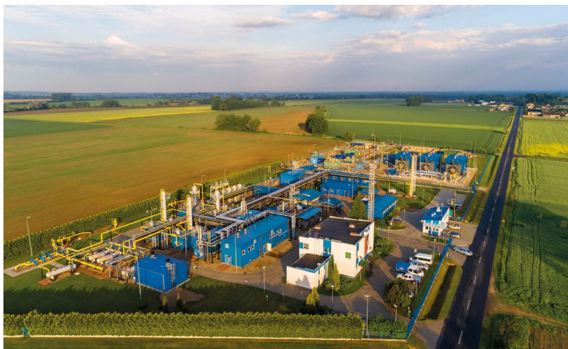
Ryc. 1. Kopalnia Gazu Ziemnego Kościan-Brońsko – największa kopalnia gazu ziemnego w Polsce
