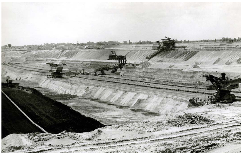
Ryc. 5. Koparki i zwałowarki, zbierające nadkład z odkrywki Kazimierz, 1973 r. (źródło: KWB Konin)
