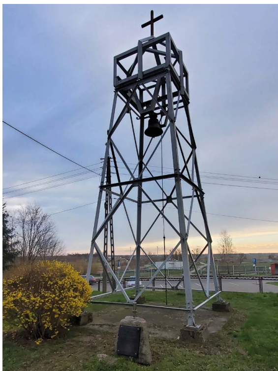
Ryc. 11. – Dzwonnica kościoła parafialnego pw. Świętej Trójcy w Górze wykorzystująca dawną konstrukcję z terenu kopalni soli oraz PMRiP Góra
