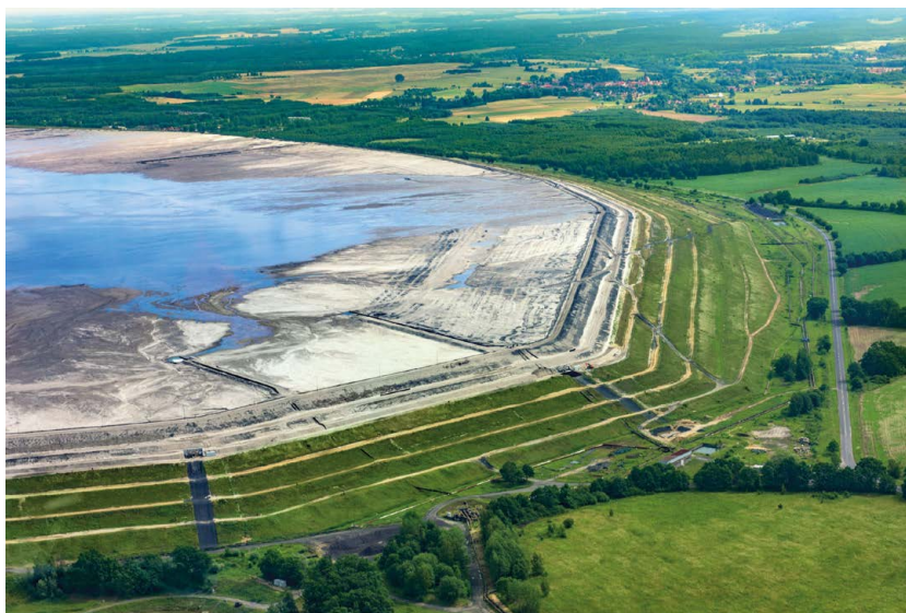
Ryc. 10. OUOW Żelazny Most – zapora północna (fot. https://media.kghm.com/pl/zdjecia/ )
