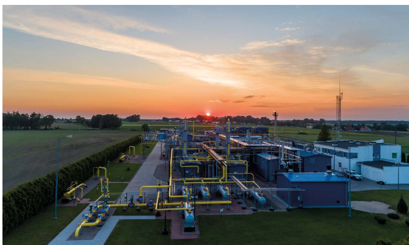
Ryc. 5. Instalacja w Kokorzynie wydobywa rocznie ok. 1,2 mld m 3 gazu zaazotowanego ze złóż Kościan i Brońsko
