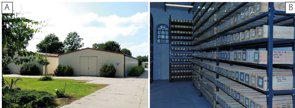
Ryc. 2. Hale magazynów próbek geologicznych (A) i archiwum stratotypowych odcinków rdzeni (B)
