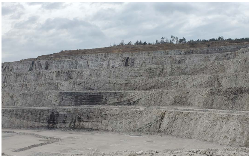
Ryc. 7. Fałd szerokopromienny na południowo-zachodniej ścianie wyrobiska Wapienno Zachód
