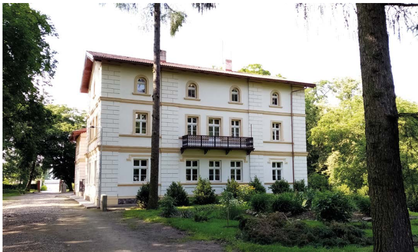
Ryc. 3. Widok dworu od strony parku
